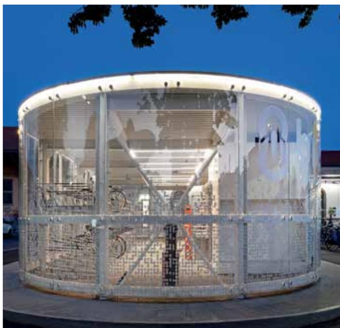
Il sistema di facciata perimetrale in vetro, che si sviluppa senza soluzione di continuità interrompendosi solo all'incontro del portale di ingresso all'edificio, è caratterizzato dalla mancanza di cornici di contenimento sostituite da ancoraggi di tipo puntuale puntualmente ovvero borchie in acciaio inox AI-
