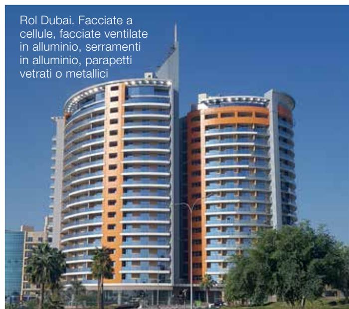
Rol Dubai. Facciate a cellule, facciate ventilate in alluminio, serramenti in alluminio, parapetti vetrati o metallici
